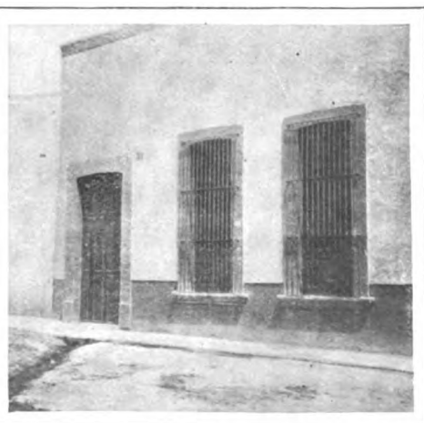
MISSION PREMISES, AGUASCALIENTES
